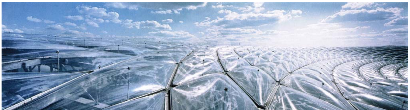
Dach der Allianz Arena München, in: LeCuyer - ETFE - Technologie und Entwurf
